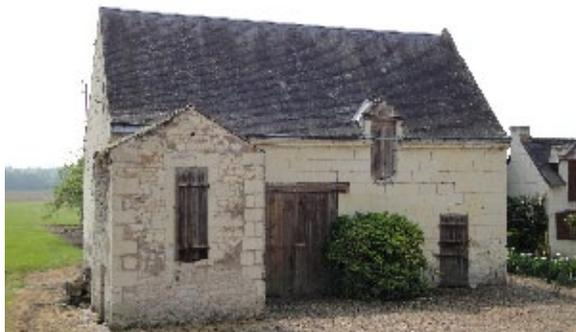
Murs en pierres de taille, murs en moellons et chaînes d'angles en pierres de taille appareillées
