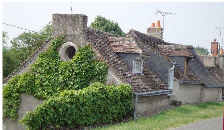
Toit de tuiles plates et d'ardoises
