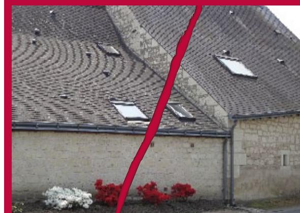
À éviter : châssis de toit de tailles différentes, non encastrés et non alignés !
