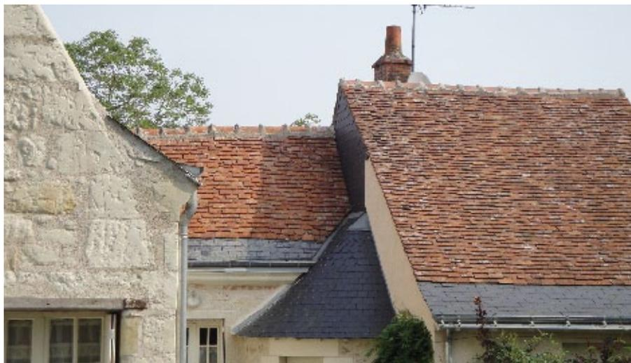
Toit de tuiles plates et d'ardoises
