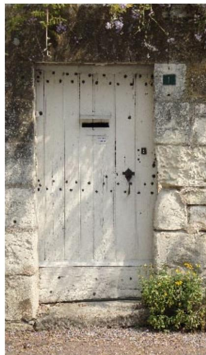
Porte en bois composée de planches jointives dans un mur de clôture
