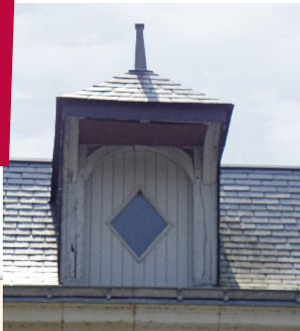
Il existe plusieurs types de lucarnes : la lucarne dite à "bâtière" ou à "fronton" à deux versants de toiture et la lucarne dite "à la capucine" plutôt visible sur les maisons de bourg, à trois versants de toiture. Les lucarnes à fronton peu pointu sont les plus répandues en Touraine. Le fronton peut être en bois ou en pierre, en fonction de son emplacement dans la toiture; il est en pierre uniquement à l'aplomb de la maçonnerie.
